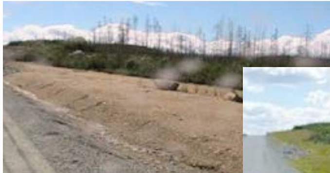
Antes de la instalación, cerca de James Bay.
