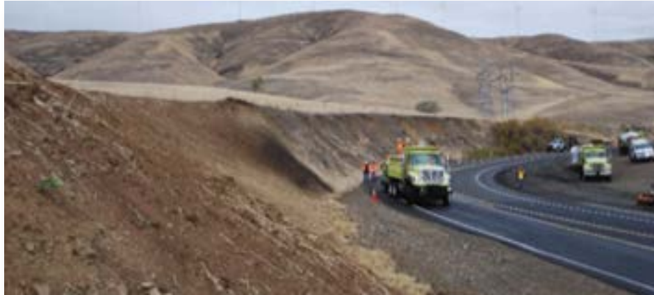
Instalación inicial: observe las condiciones extremadamente áridas.
